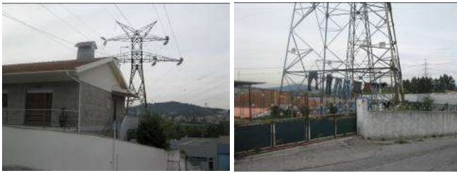
Figura 2 – Postes de alta tensão fazem parte dos quintais das habitações em Serzedelo
